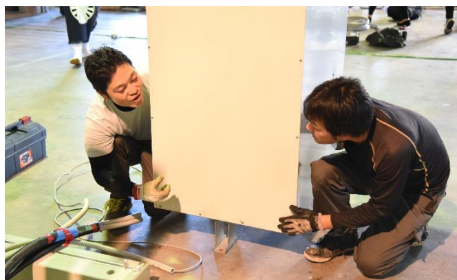
コミュニケーションをとりながらエコキュート設置作業を行う様子
